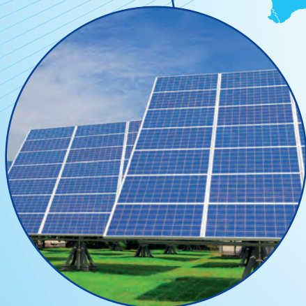
Solar Power Plant 太阳能发电站
