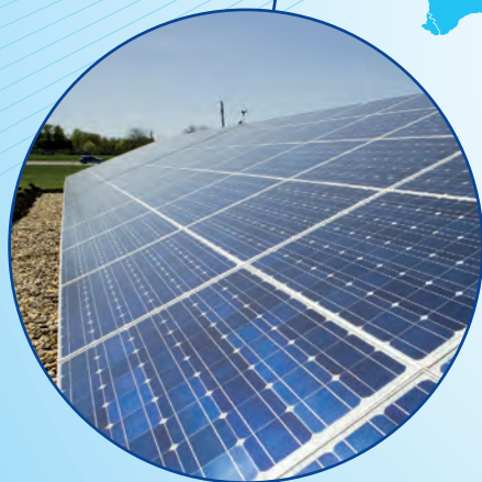
Solar Power Plant 太阳能发电站
