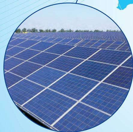
Solar Power Plant 太阳能发电站
