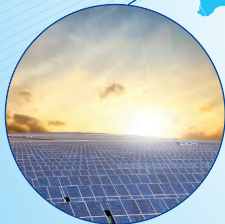
Solar Power Plant 太阳能发电站
